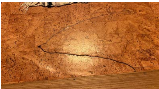
Sprekk i gulvbelegget
