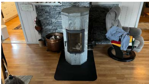
Vedovn i 1. etasje
