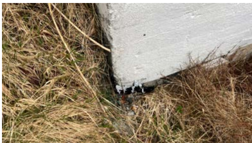
Grunnmur med utvendig fuksikring
