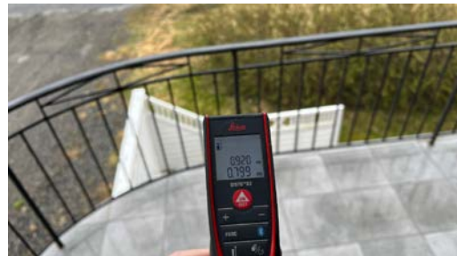
Rekkverk i stål
