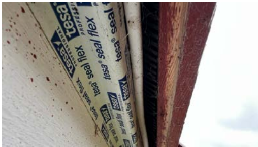
Luftet bordkledning. Musebånd er montert på kotrollert område
