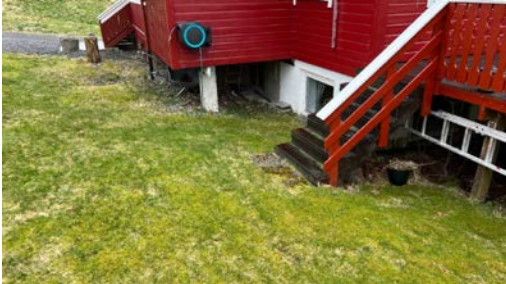
Terrenget heller inn mot murene
