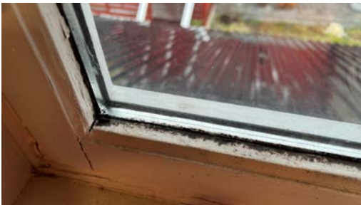
Baderomsvidnuet i 2. etasje
