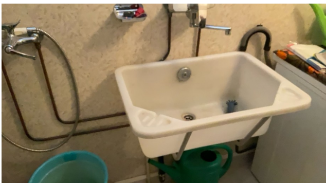
KJELLER/ UNDERETASJE > VASKEROM
