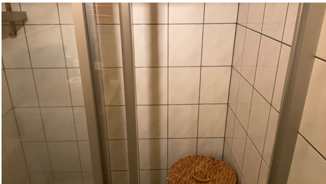
KJELLER/ UNDERETASJE > BAD
