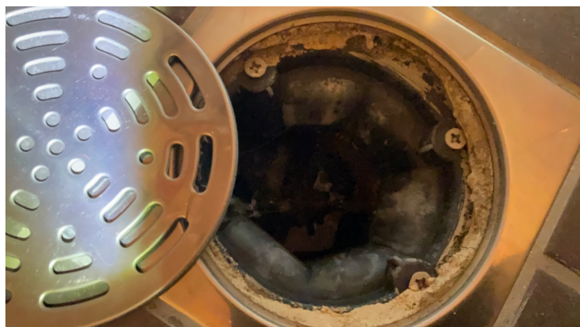
Eldre sluk uten synlig mansjett eller membran
