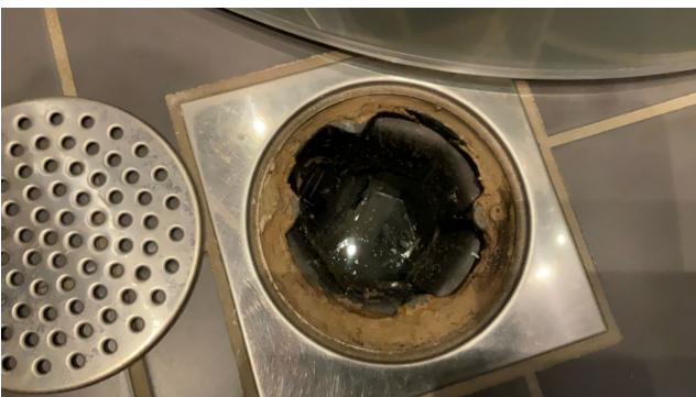
Sluk uten synlig membran/ mansjett
