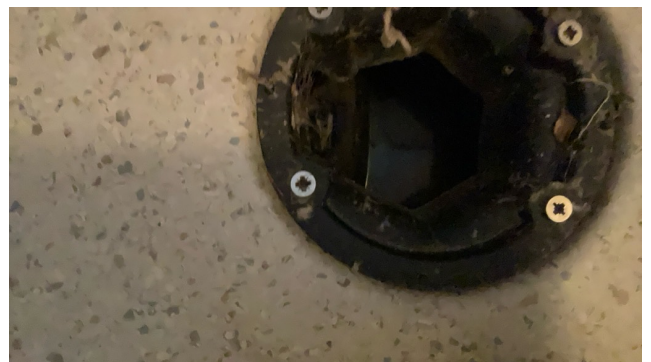
KJELLER/ UNDERETASJE > VASKEROM
