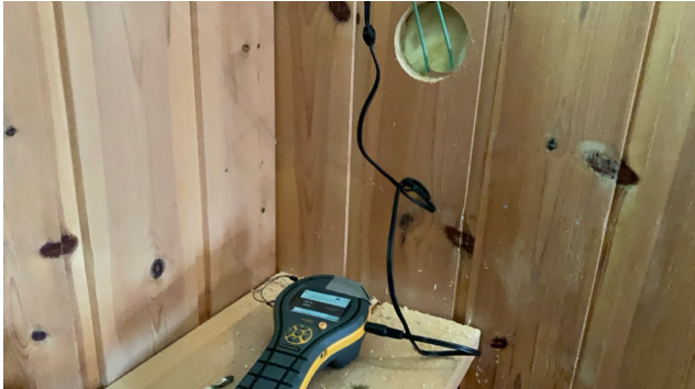
KJELLER/ UNDERETASJE > VASKEROM
