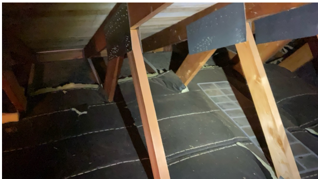
Luftespalter tettet med isolasjon
