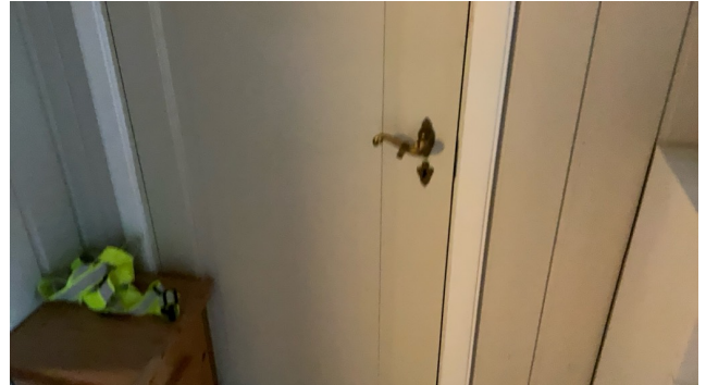
Det er etablert åpning med enkel dør mellom del som leies ut og hoveddel av boligen.
