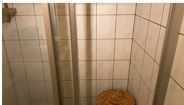
KJELLER/ UNDERETASJE > BAD
