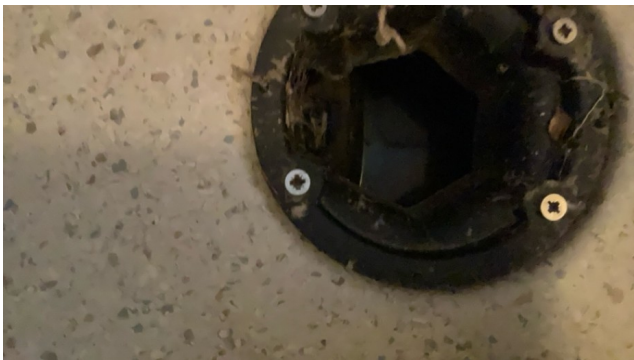
KJELLER/ UNDERETASJE > VASKEROM
