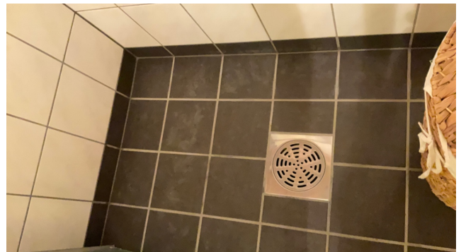
KJELLER/ UNDERETASJE > BAD
