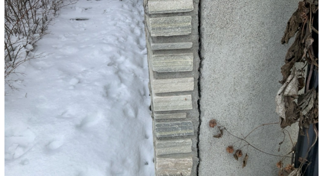
Forblending utenpå mur med sprekkdannelser mot mur.
