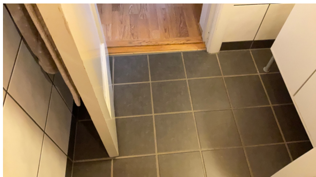
KJELLER/ UNDERETASJE > BAD
