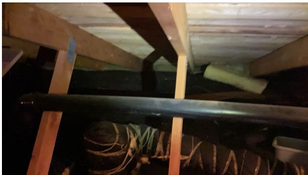
Luftespalter tettet med isolasjon
