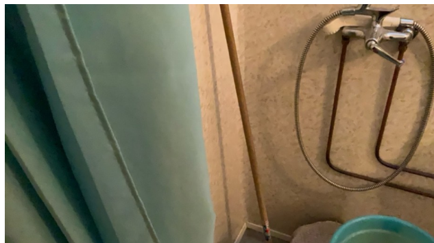
Belegg opp utenpå tapet vegg, dekket med list.
