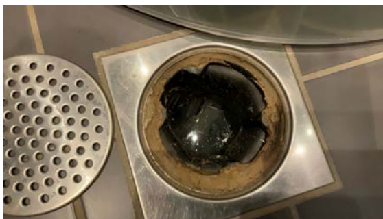
Sluk uten synlig membran/ mansjett
