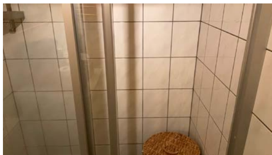
KJELLER/ UNDERETASJE > BAD
