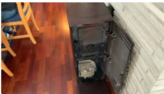
Kamin tilkoblet dagtank i garasje.
