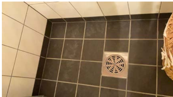
KJELLER/ UNDERETASJE > BAD
