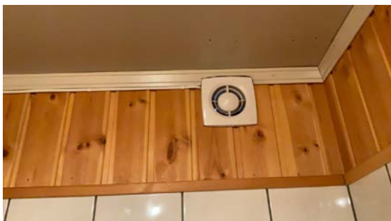
KJELLER/ UNDERETASJE > BAD
