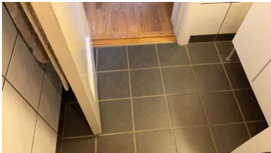
KJELLER/ UNDERETASJE > BAD
