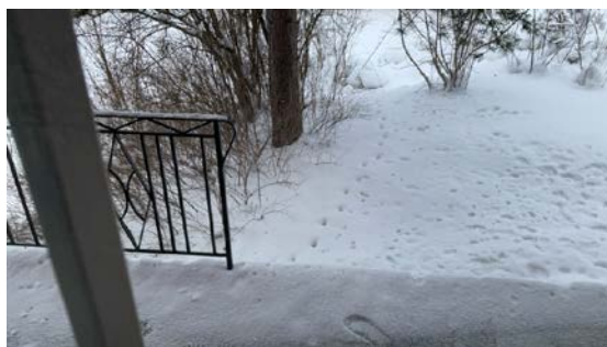
Manglende rekkverk på deler av terrasse i stueende.
