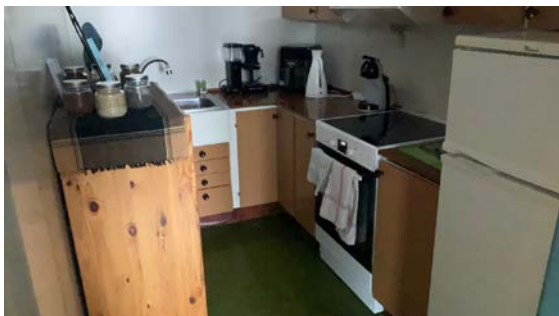
Innredning og vannrør i vegg mot våtsoner bad
