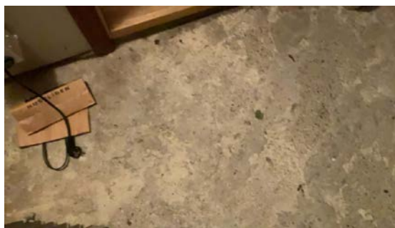
Gulv i kjeller
