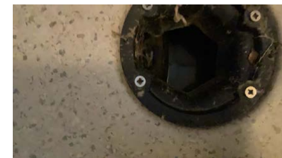
KJELLER/ UNDERETASJE > VASKEROM
