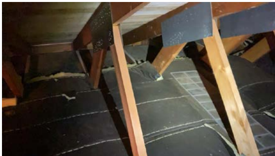
Luftespalter tettet med isolasjon
