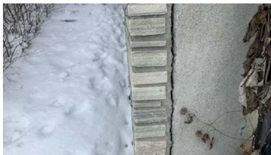
Forblending utenpå mur med sprekkeformasjoner mot mur.
