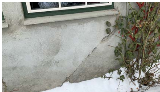
Skråriss ved vindu stue underetasje
