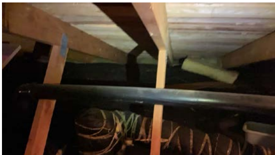
Luftespalter tettet med isolasjon
