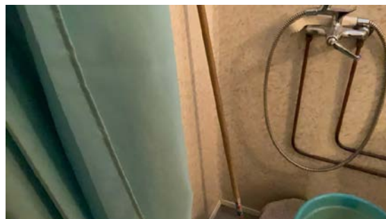
Belegg opp utenpå tapet vegg, dekket med list.
