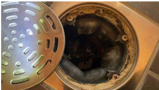
Eldre sluk uten synlig mansjett eller membran
