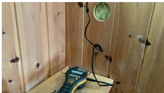
KJELLER/ UNDERETASJE > VASKEROM
