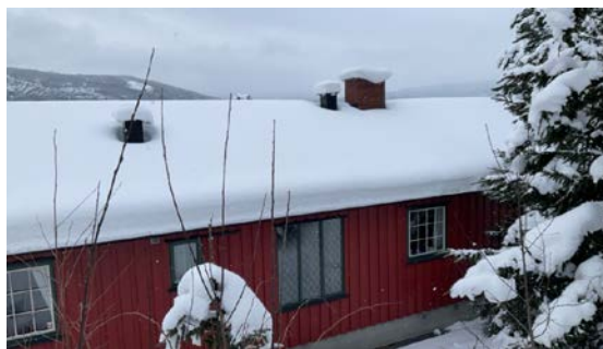
Tak dekket med snø ved befaringen
