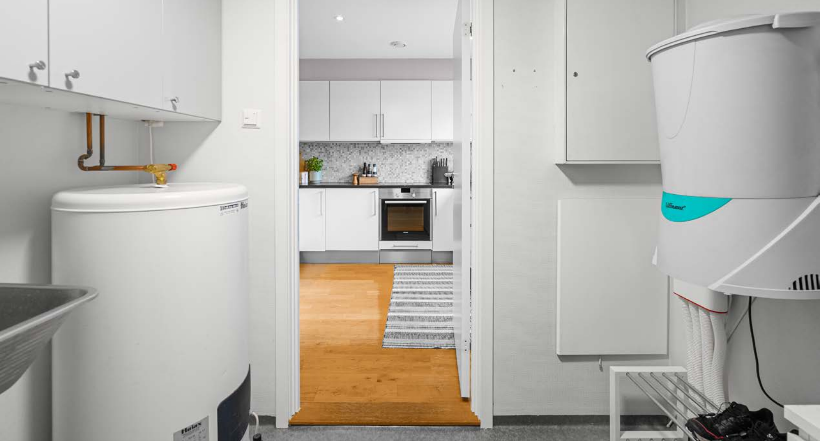
Boligen har sentralstøvsuger og balansert ventilasjon. Nyere vegghengte skap til oppbevaring.
