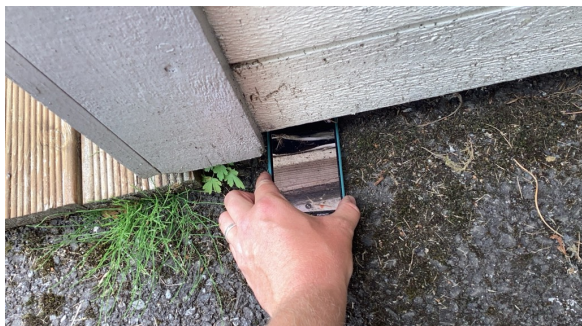
Sjekk av lufting.
