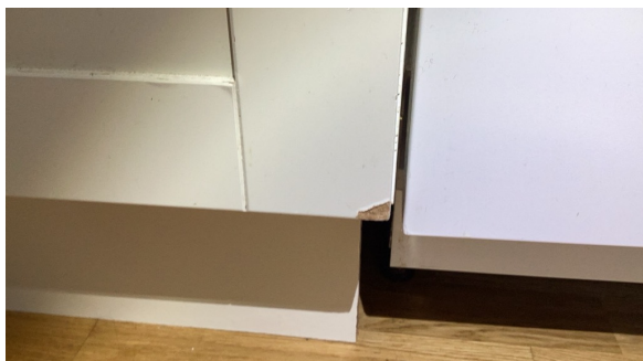
Svelleskade på skapdør.
