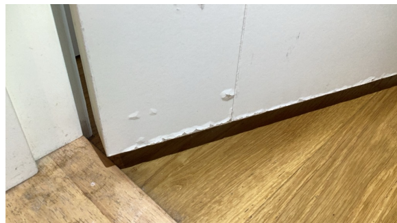
Noe svelling nederst på dørblad til bad.
