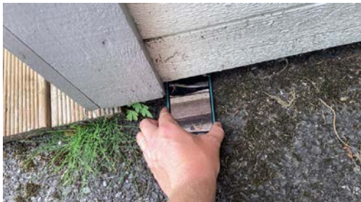
Sjekk av lufting.
