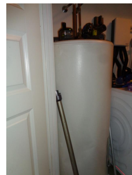
Varmtvannsbøder på vaskerom.
