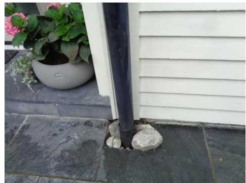
Nedløp til rør i bakke.
