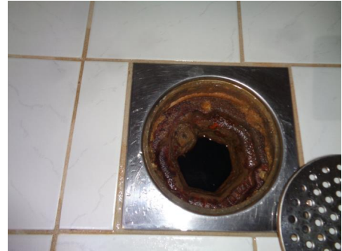
Eldre sluk i dusjsone.
