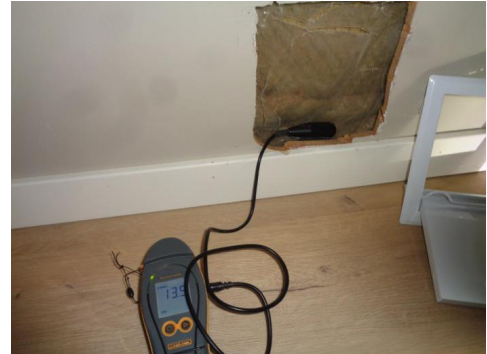
Ingen unormale fuktverdier registrert.
