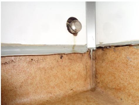
Plugget rør i dusjsone.
