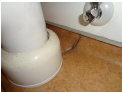
Plugget rør i dusjsone.
