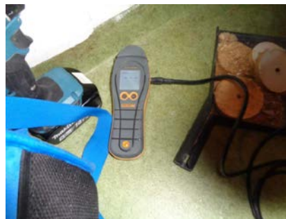
Det ble ikke målt unormale fuktverdier i konstruksjoner.
