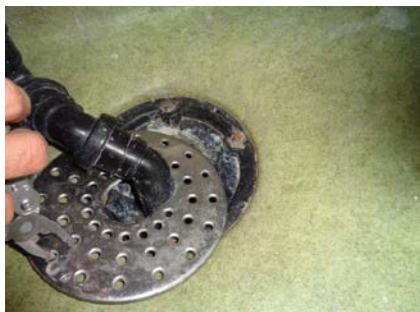
Plastsluk på vaskerom.
