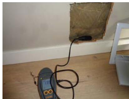
Ingen unormale fuktverdier registrert.
