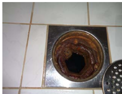
Eldre sluk i dusjsone.
