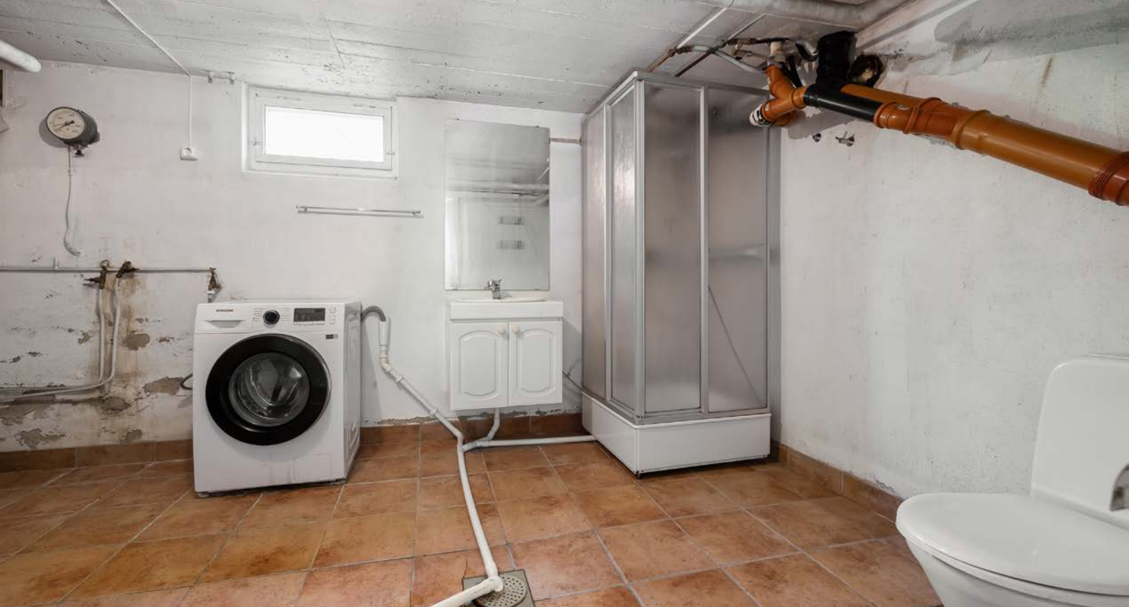
Vaskerom/bad/teknisk rom i kjeller med flislagt gulv.
