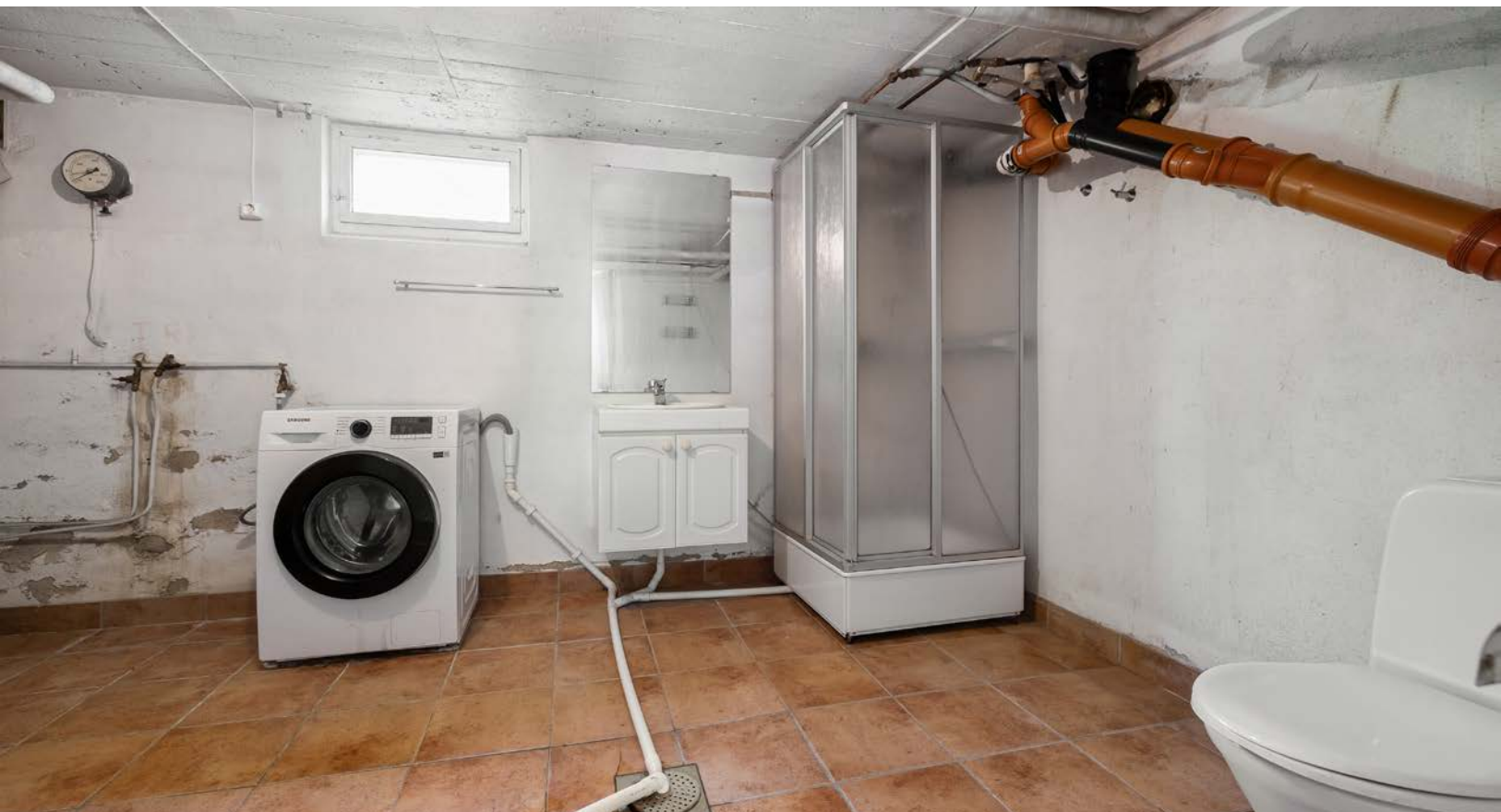
Vaskerom/bad/teknisk rom i kjeller med flislagt gulv.
