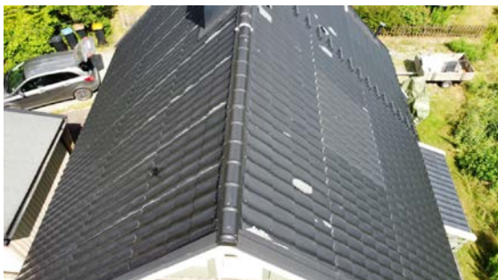
Bildet viser taket uten snøfangere.
