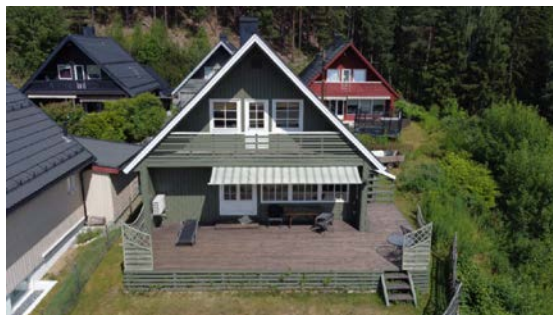
Bildet viser terrassene med manglende rekkverk.
