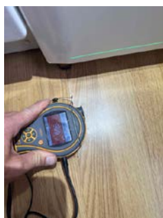
Bildet viser indikasjon på fuktutslag.
