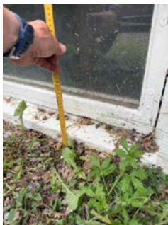
Bildet viser kjellervindu som er plassert nær terreng.
