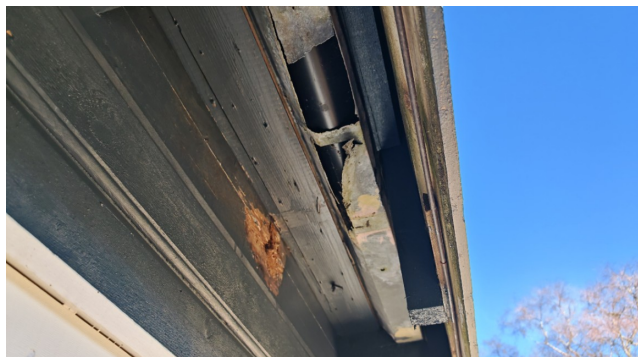
Mindre skade etter utbedring av takrenne.
