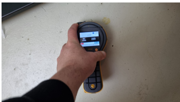
Det ble registrert forhøyde fuktverdier.
