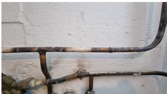
Eldre vannledninger av kobber.
