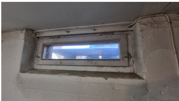
Vindu fra byggeår.
