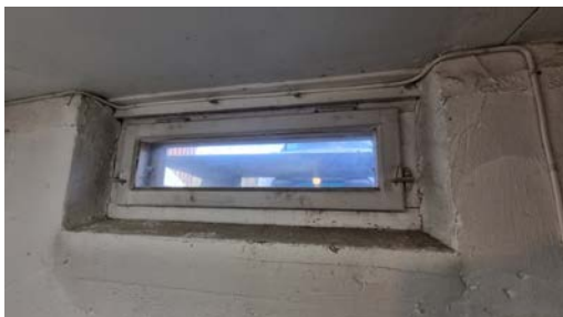
Vindu fra byggeår.
