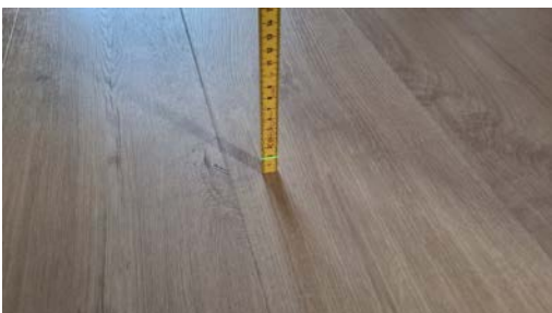
Kontroll av planavvik.
