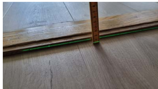
Kontroll av planavvik.
