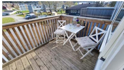
Takterrasse på fasade mot nord.
