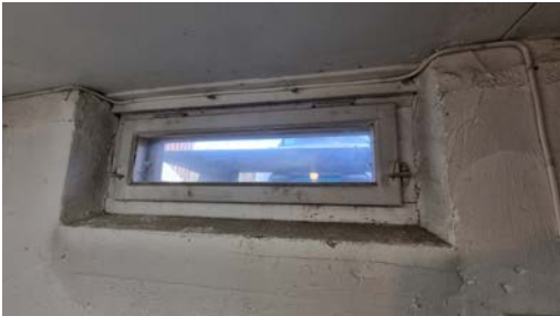
Vindu fra byggeår.
