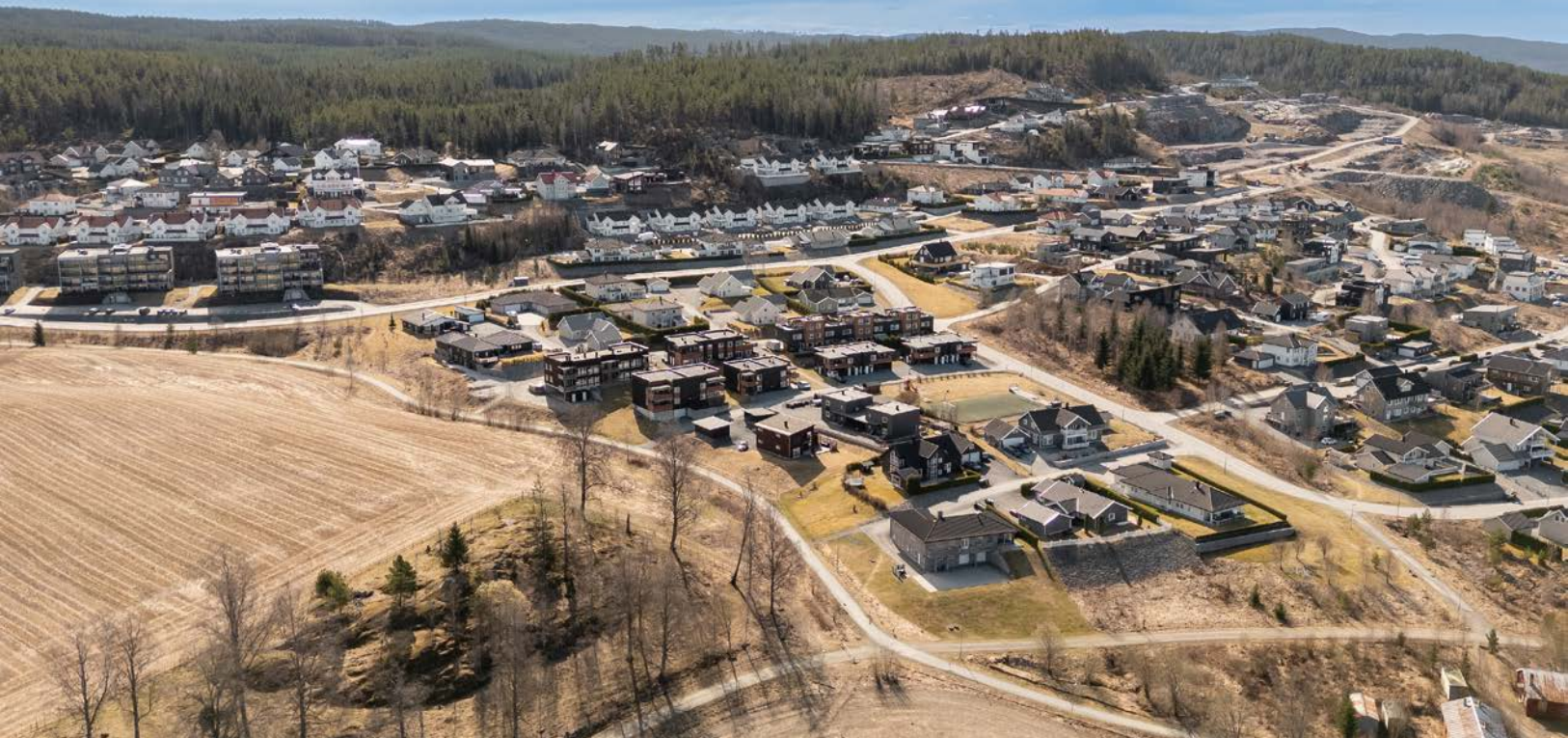
Dronefoto over Festningsåsen. Leilighetsbygget kan sees omtrent midt i bildet. Firemannsboligen ligger nær åkre og grøntområder.
