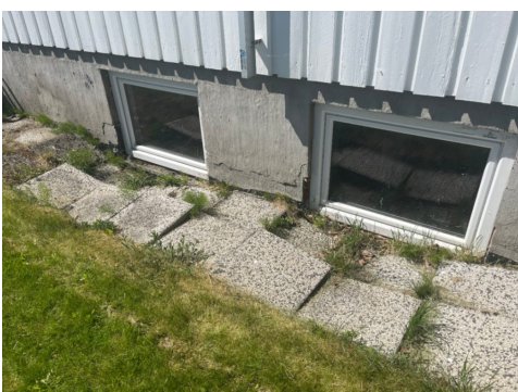
PVC kjellervinduer er ikke ferdigstilt.
