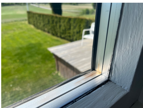
Vindu leilighet med tegn til punkttert glass.
