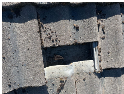
Betongtakstein med papp undertak iht. stikkprøver.
