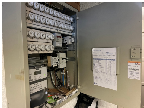
Sikringsskap hoveddel.
