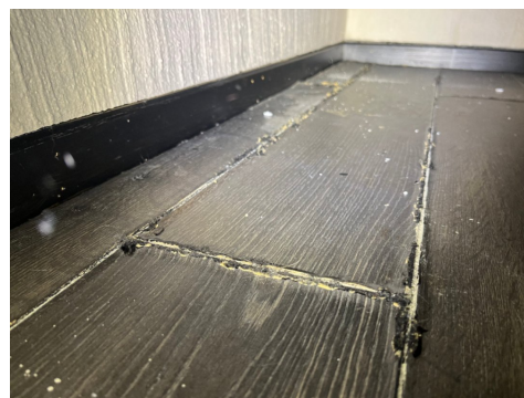
Fuktskadet laminatgulv.
