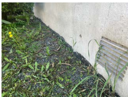
Synlig grunnmursplast på grunnmur.
