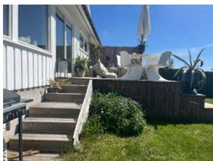
Trapp til terrasse.
