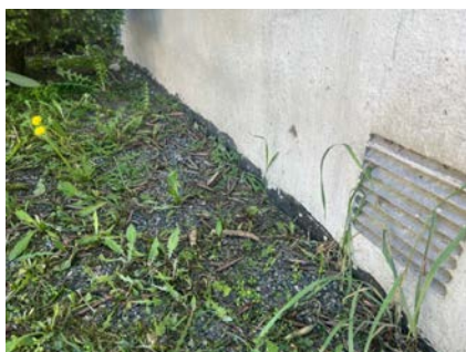
Synlig grunnmursplast på grunnmur.
