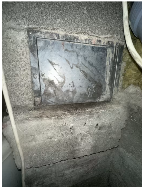
Sotluke plassert i kjeller.
