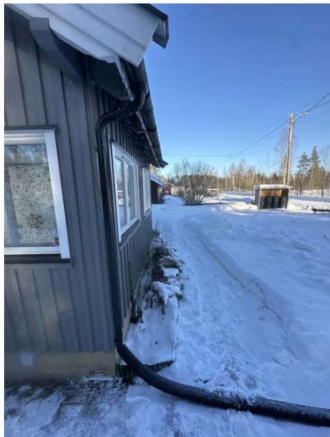
Takvann ledes vekk fra grunnmur med drenerør.
