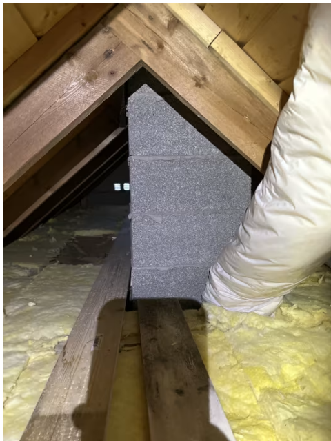
Viser pipe på loft.
