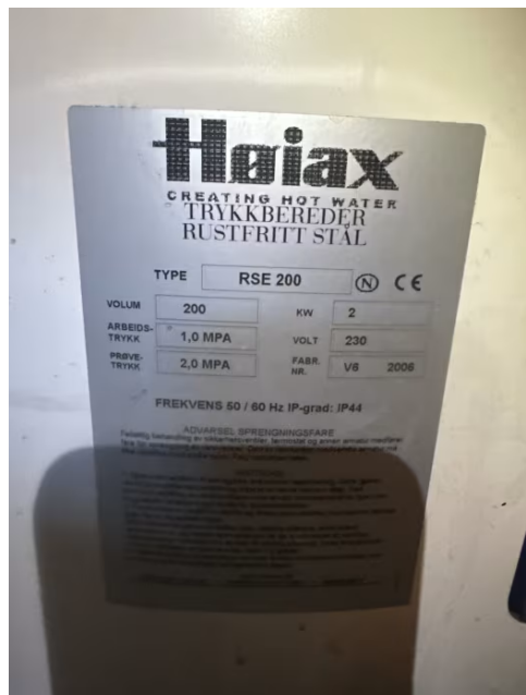
Viser teknisk data på bereder.
