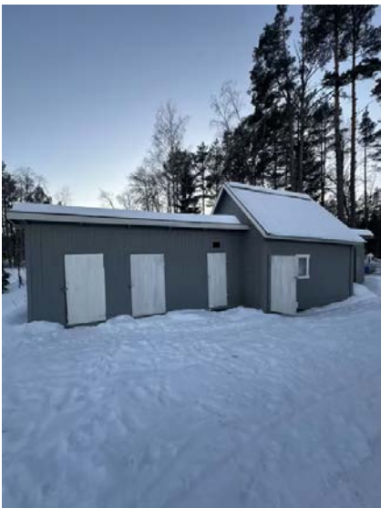
Viser uthus med boder.
