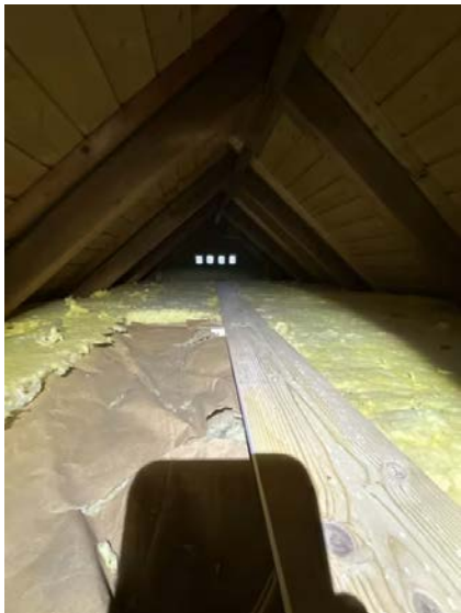
Viser kaldtloft isolert med mineralull. Lufteventiler i gavlvegg.
