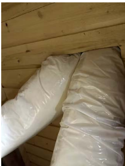
Ingen synlige fuktskjolder eller lekkasjer ble påvist ved takgjennomføringer.
