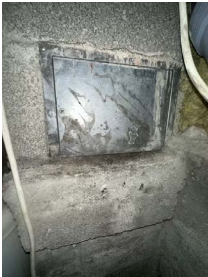
Sotluke plassert i kjeller.
