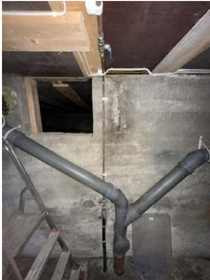
Viser avløpsrør og stakeluke i kjeller.
