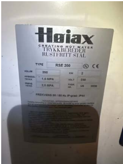
Viser teknisk data på bereder.
