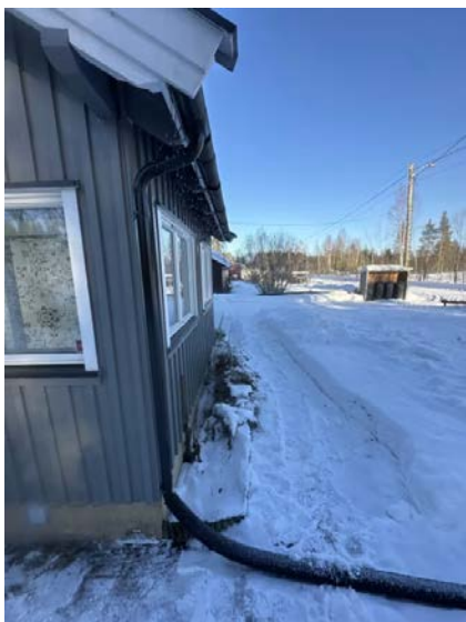
Takvann ledes vekk fra grunnmur med drensør.
