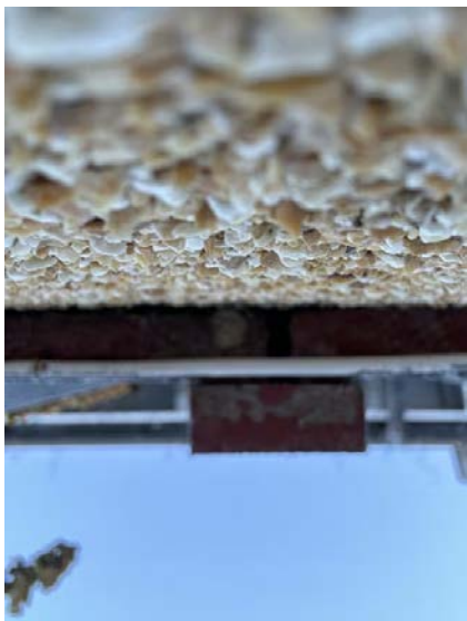
Ettermonterte grunnmursplater tetter for lufting av kledningen.
