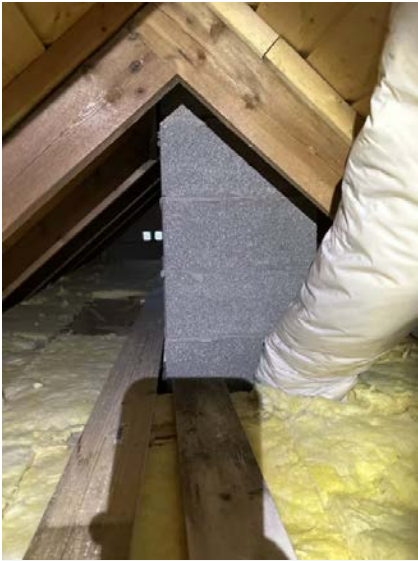
Viser pipe på loft.
