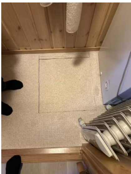
Viser adkomst til krypkjeller under tilbygg. Luke i gulv i bod.
