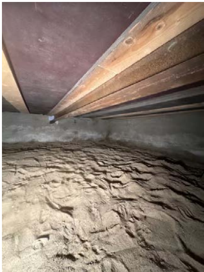
Det registreres rustdannelser på H - bjelke i krypkjeller.
