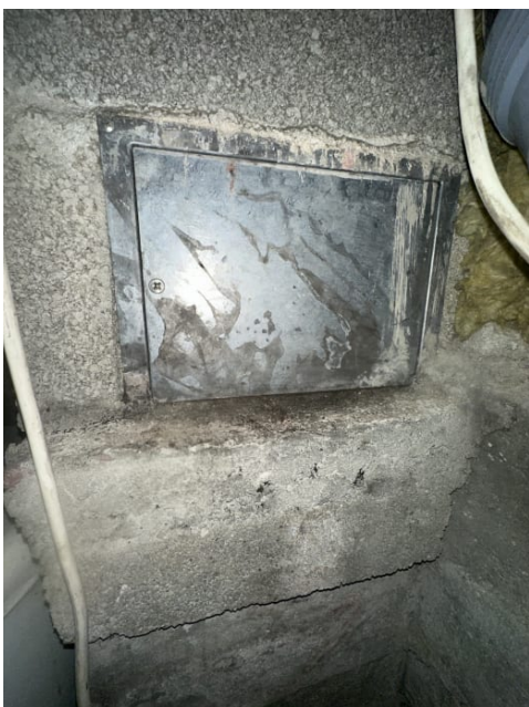
Sotluke plassert i kjeller.
