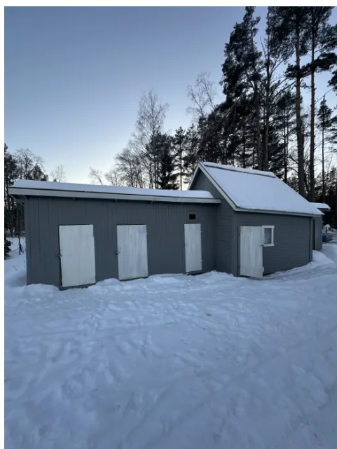
Viser uthus med boder.
