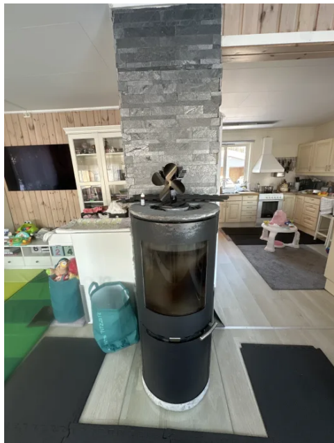
Viser ildsted i stue. Glassplate montert under ildsted.
