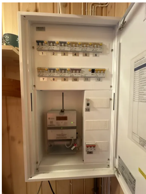
Viser vegghengt sikringsskap plassert i bod 1.etasje med overbelastningsvern 40A, måler og jordfeilbrytere.
