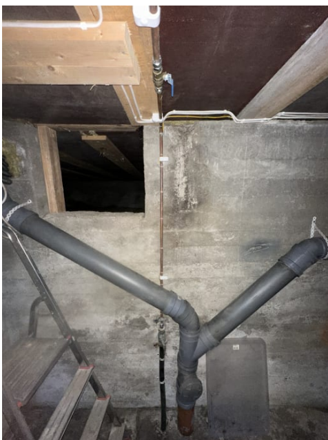
Viser avløpsrør og stakeluke i kjeller.
