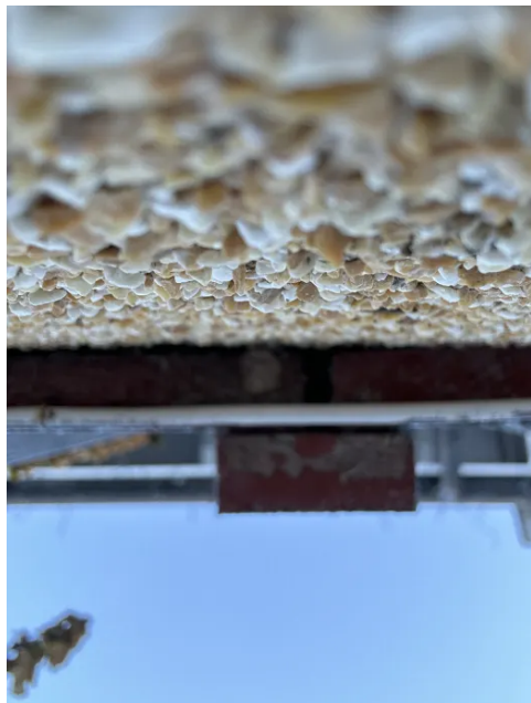
Ettermonterte grunnmursplater tetter for lufting av kledningen.
