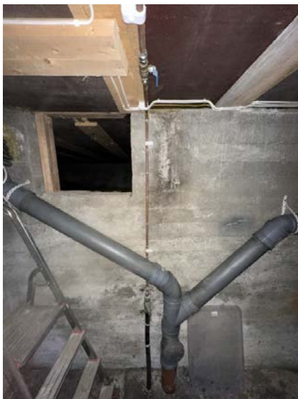
Viser avløpsrør og stakeluke i kjeller.
