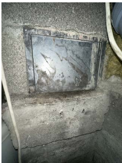
Sotluke plassert i kjeller.
