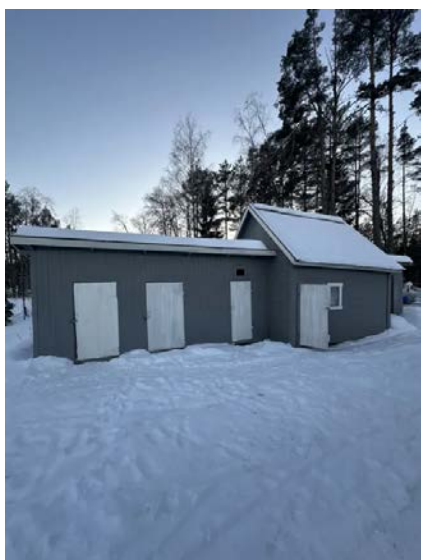
Viser uthus med boder.
