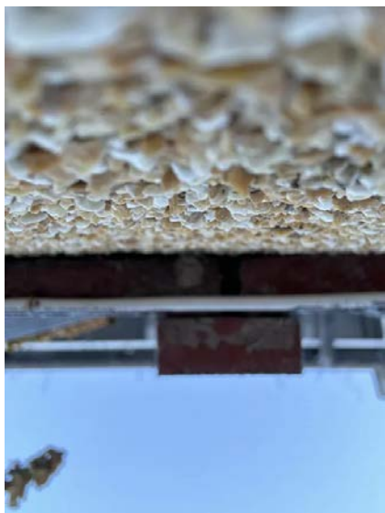
Ettermonterte grunnmursplater tetter for lufting av kledningen.
