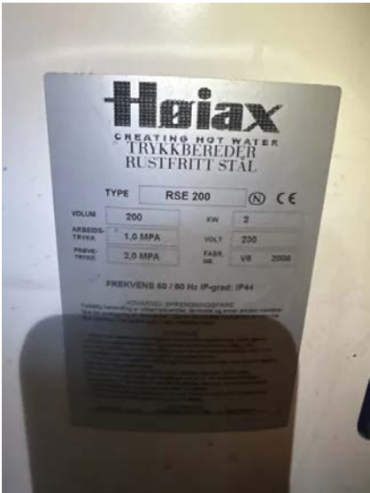
Viser teknisk data på bereder.
