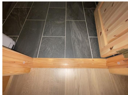
Standard dørterskel uten tilluft
