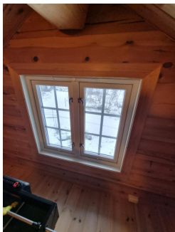
Vindu på hems med fast midtdeler, ikke godkjent rømningsvindu
