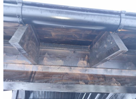
Synlige luftespalte ved overgang tak/vegg
