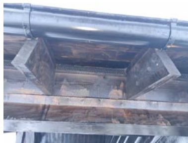
Synlige luftespalte ved overgang tak/vegg
