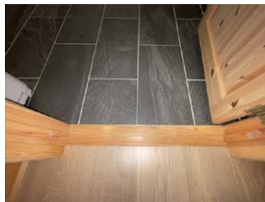
Standard dørterskel uten tilluft
