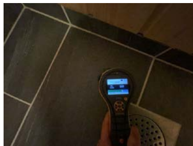
Fuktsøk er utført på gulv ved vaskekum og sluk uten forhøyde fuktavvik.
