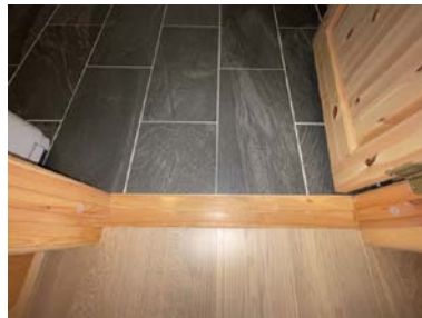
Standard dørterskel uten tilluft
