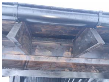
Synlige luftespalte ved overgang tak/vegg
