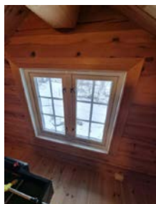
Vindu på hems med fast midtdeler, ikke godkjent rømningsvindu
