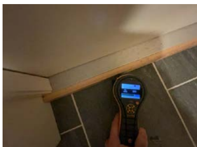
Fuktsøk er utført på gulv ved utgangsdør uten forhøyde fuktavvik.
