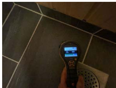
Fuktsøk er utført på gulv ved vaskecum og sluk uten forhøyde fuktavvik.
