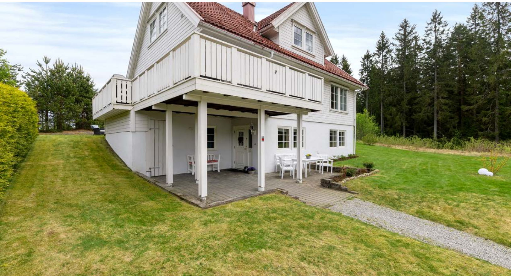
Koselig overbygget inngangsparti med belegningsstein og plass til utemøblement.
