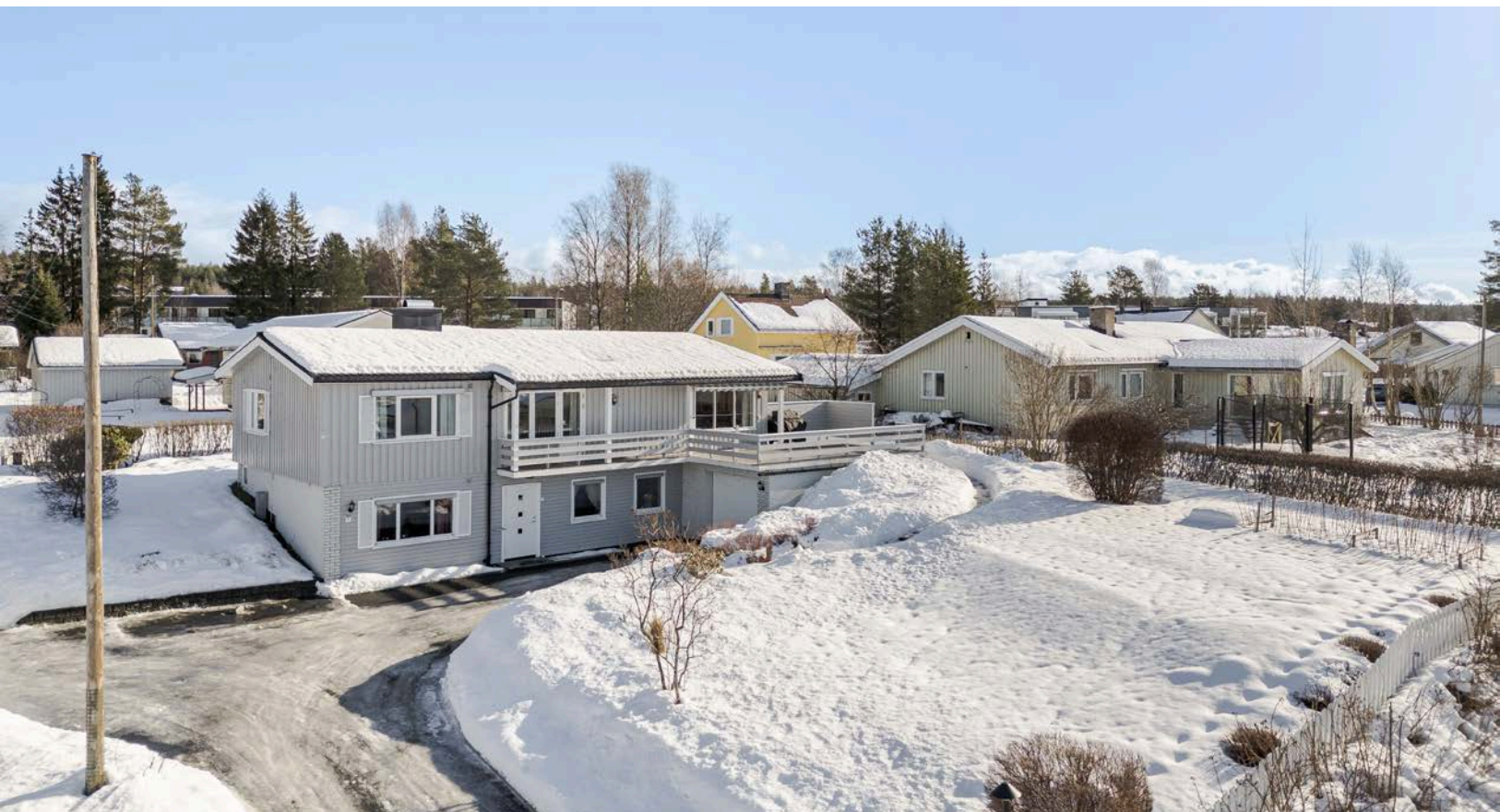
En stor og solrik eiendom som er bebygd med en enebolig fra 1959 med inntilbygget garasje.
