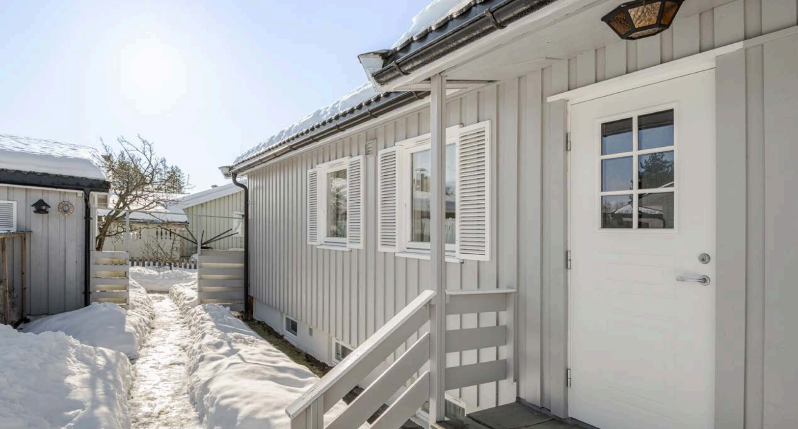
Fra vaskerommet kommer du ut til baksiden av boligen.
