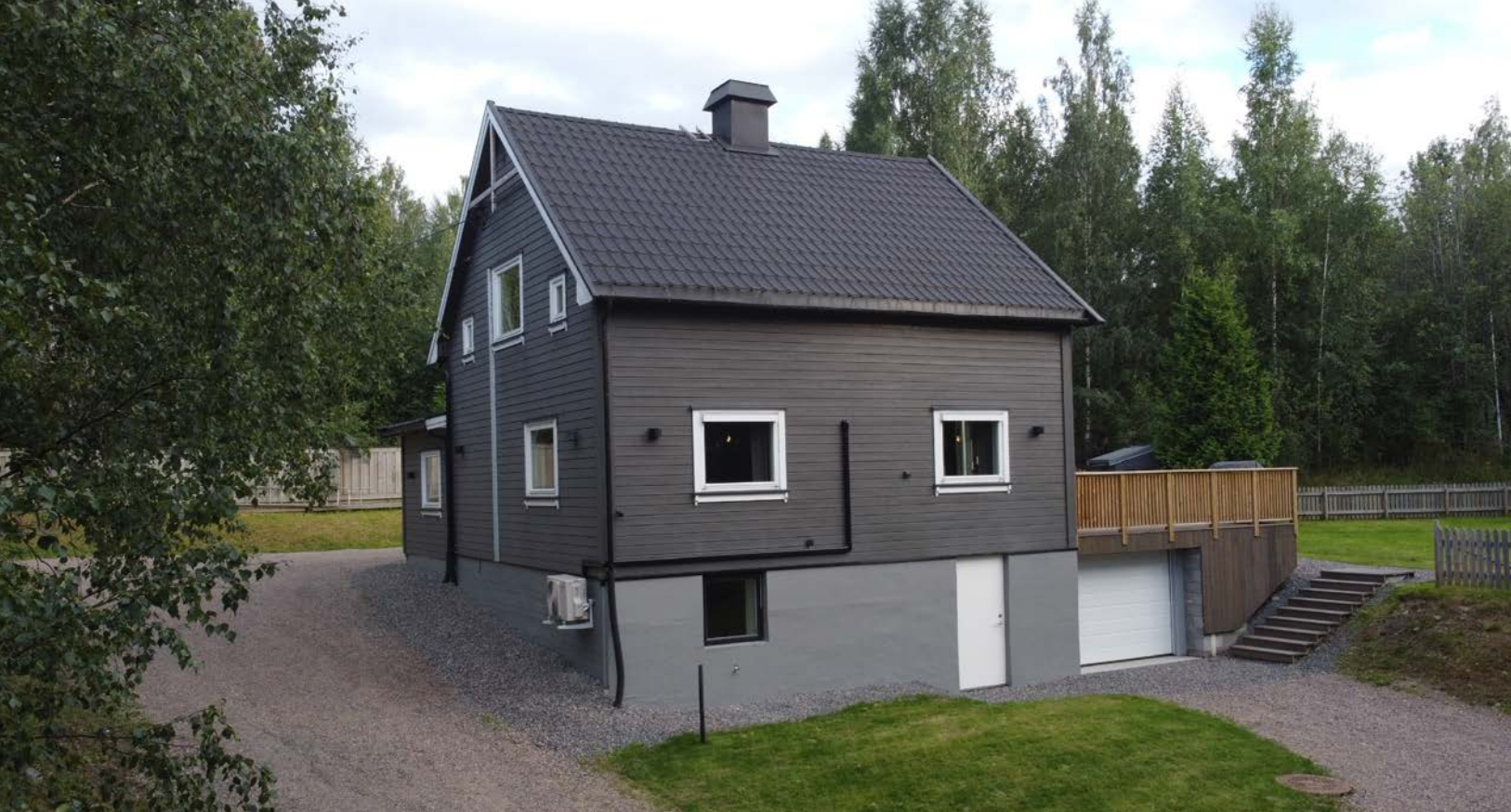
Trapp i terrenget fra garasje til hage.
