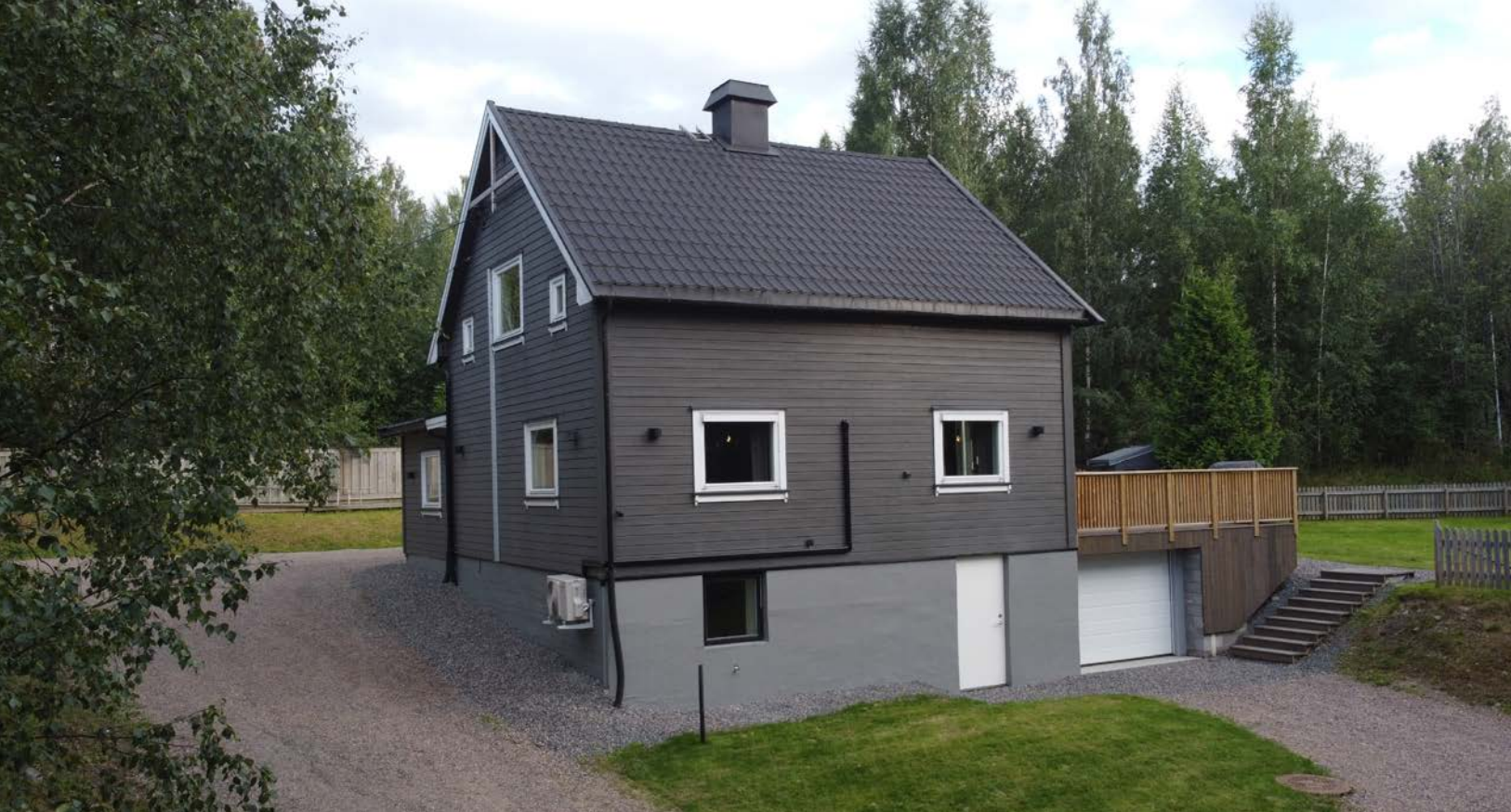
Trapp i terrenget fra garasje til hage.
