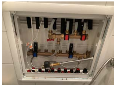
Vannfordelerskap i bad i 1. etg.
