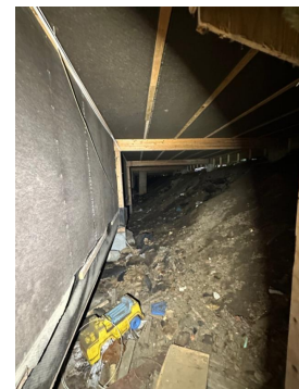
Bilde fra kryperom under kjøkkenet. Åpning under inngang, bad m.m., er ned til venstre i bilde.
