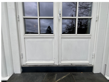
Slitt treverk på verandadøren
