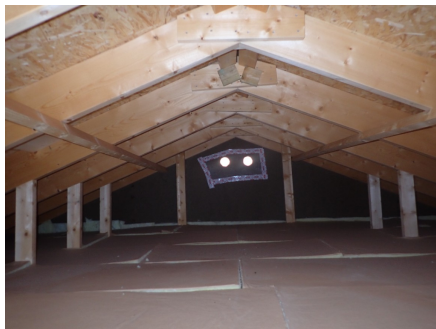
Kaldtloft over tilbygg.
