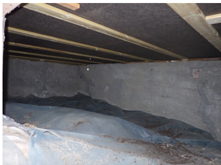
Bilde tatt i tilgjengelig del av krypkjeller
