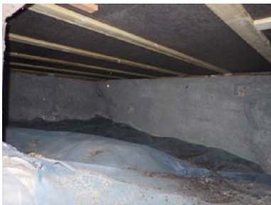
Bilde tatt i tilgjengelig del av krypkjeller
