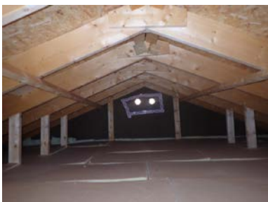
Kaldtloft over tilbygg.
