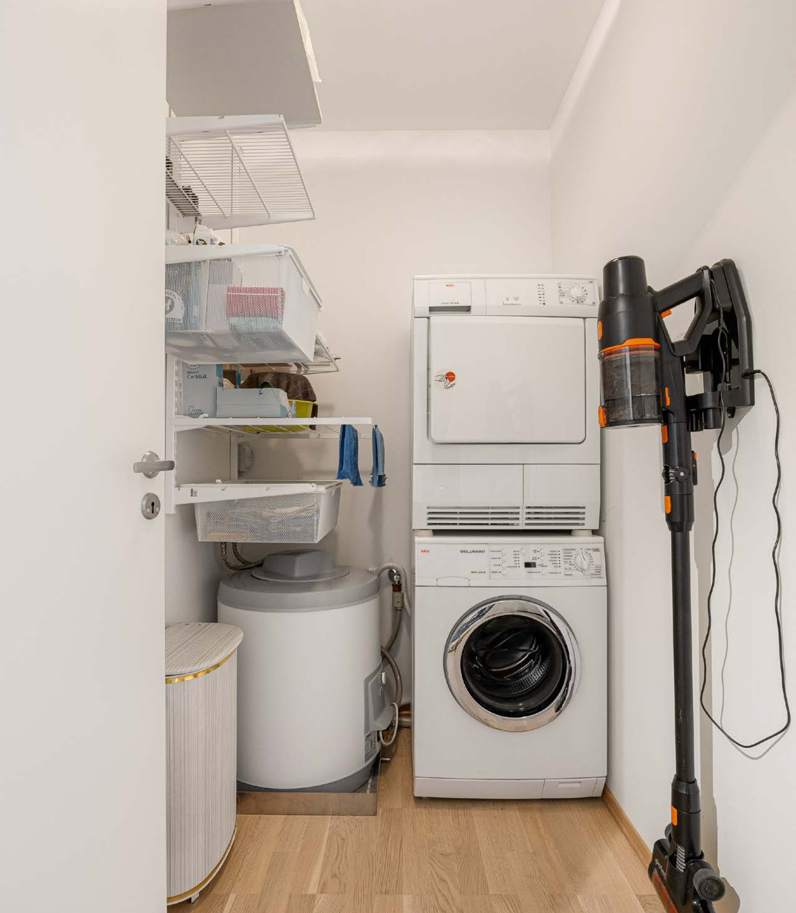
Vegg-i-vegg med badet ligger et vaskerom, men det er ikke bygd opp som våtrom. Vaskerommet er bod på byggetegninger.
