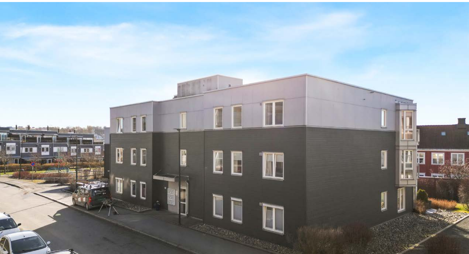
Det er heis i bygget ned til parkeringsplass i felles garasjeanlegg
