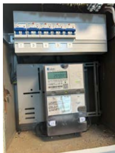
Sikringsskap med automatsikringer.
