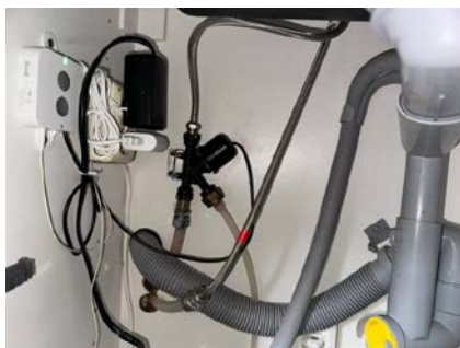
Røropplegg i kjøkkenbenk med Waterguard
