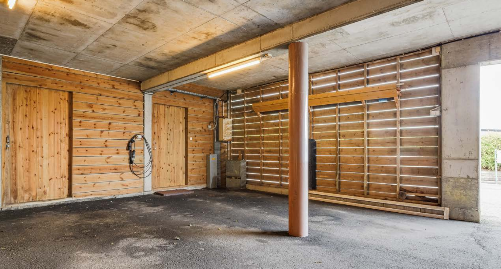
Carport/felles garasjeanlegg med 1 stk. fast parkeringsplass - felles gjesteparkering like ved
