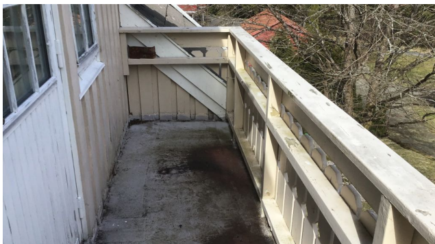
Terrasse på loft
