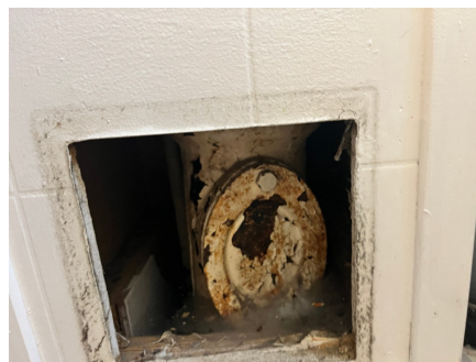
Stakepunkt bad 1 etasje
