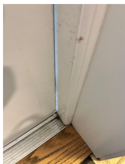
Fuktskadet balkongdør 1 etasje
