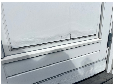
Fuktskadet balkongdør 1 etasje
