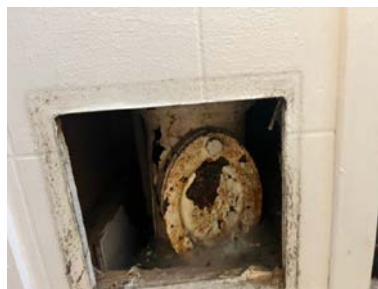
Stakepunkt bad 1 etasje
