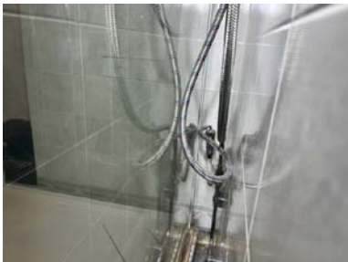
Rørgjennomføring i vegg bak dusjkabinett
