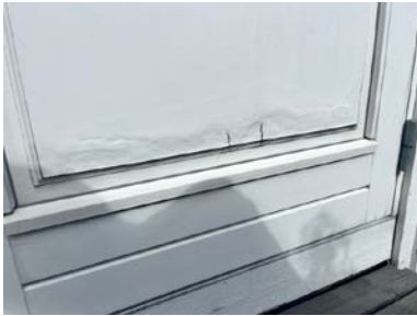
Fuktskadet balkongdør 1 etasje
