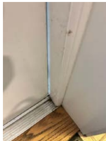
Fuktskadet balkongdør 1 etasje
