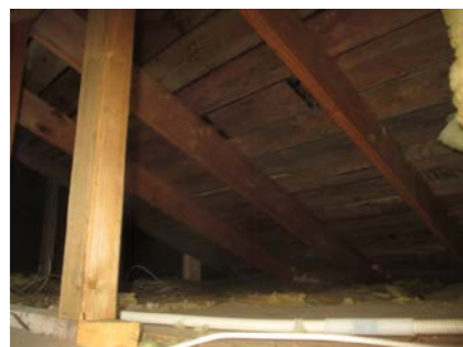
Sperrekonstruksjon med bord som undertak.
