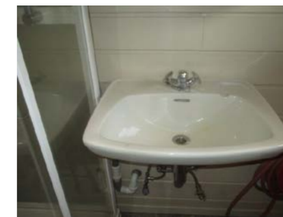
Ingen sluk i gulvet og ingen fuksikring i overgang gulv/vegg.
