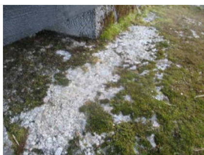
Lecablokker direkte på fjell.
