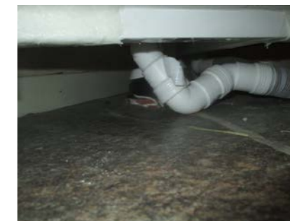
Ingen sluk i gulvet og ingen fuksikring i overgang gulv/vegg.
