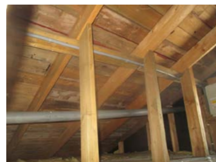
Deler av takkonstruksjonen over soverommene.
