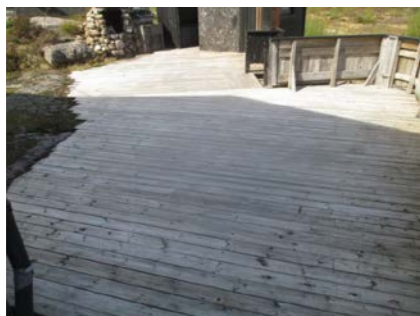
Terrasse med rekkverk.
