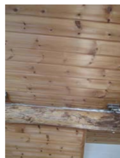
Lukket takkonstruksjon i stue/kjøkken.
