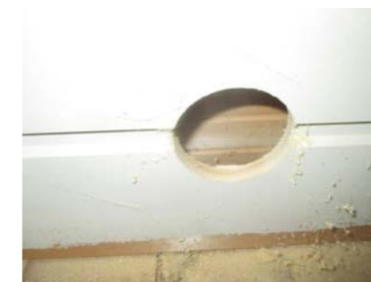
Hulltaking i fra kjøkkeninnredning.
