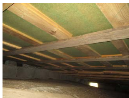
Deler av underliggende stubbloft.
