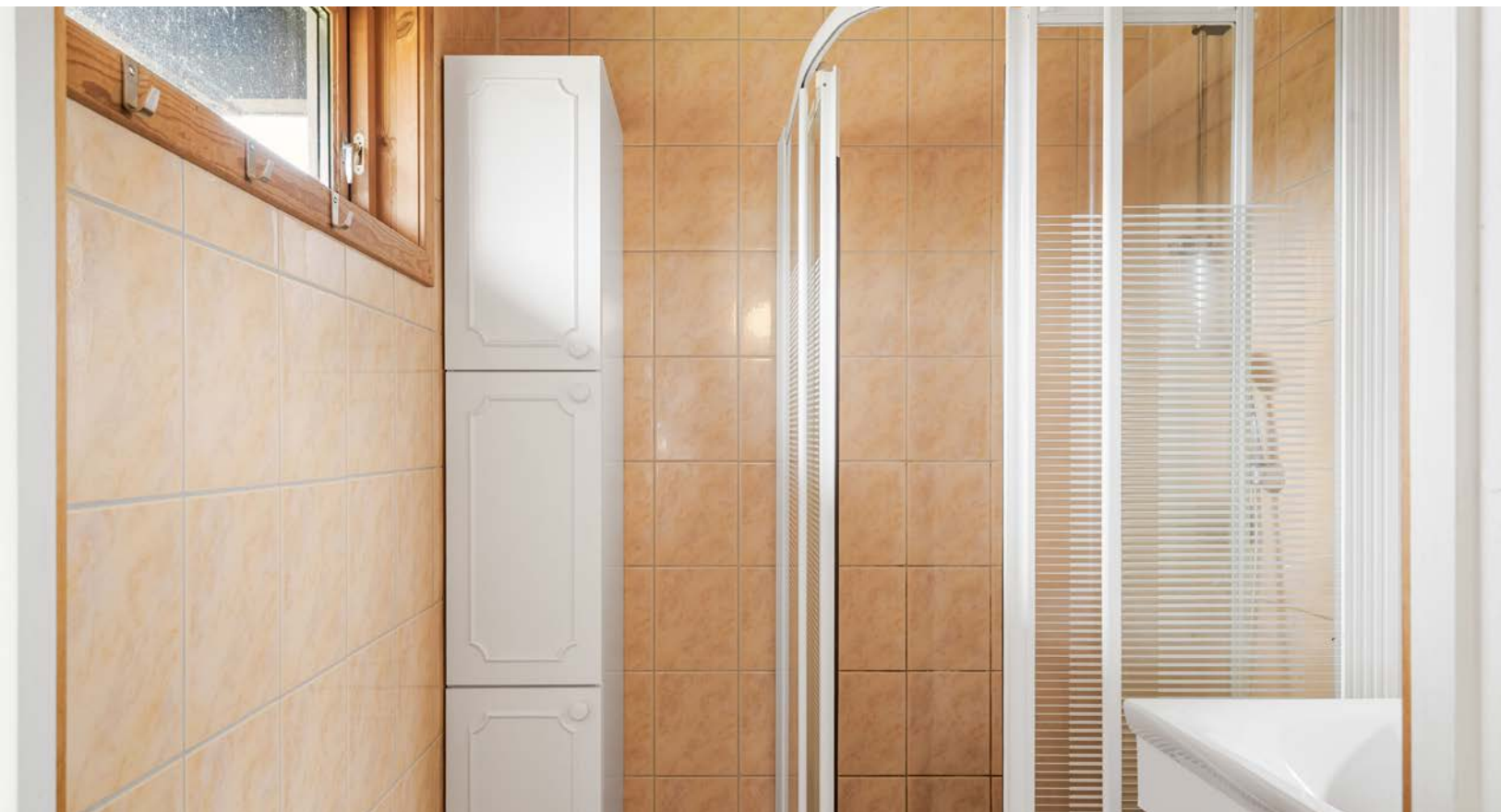
Baderom med overflater, installasjoner og komponenter fra ca. 2005. Baderommet har fliser på gulv og vegger, samt elektrisk styrt vifte.
