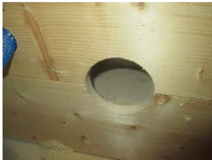
Hulltaking i fra teknisk rom.
