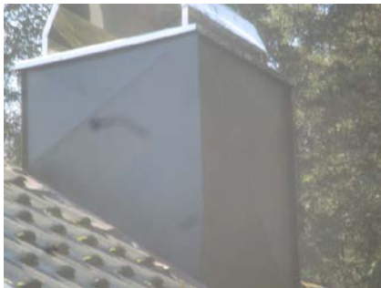
Pipe er blitt helbeslått over tak.
