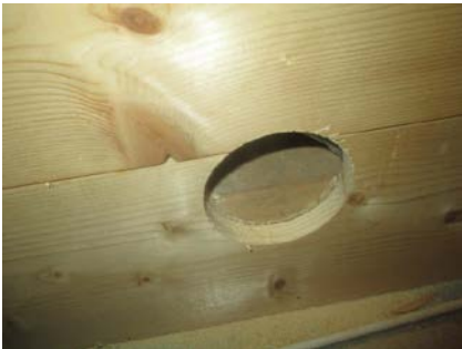
Hulltaking i utfored vegg på teknisk rom.
