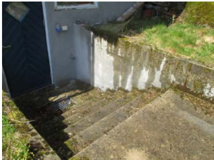
Støpt utvendig trapp til kjeller.
