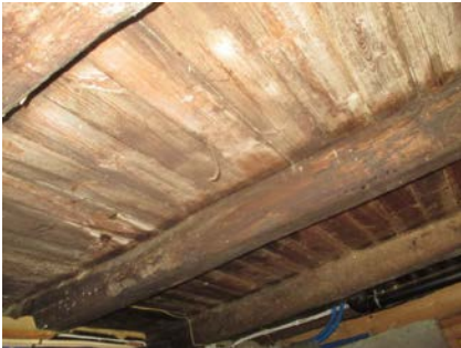
Etasjeskille til kjeller er ikke isolert i opprinnelig del.
