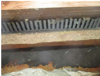
Opprinnelig fasade har ny vindtetting og lufting.
