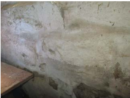
Grunnmur i grovkjeller.
