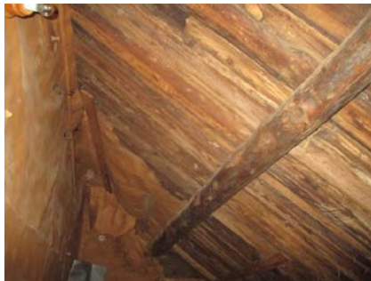
Deler av takkonstruksjonen.
