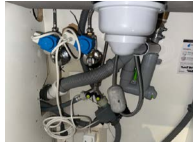
Røropplegg i kjøkkenbenk med Waterguard
