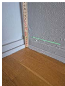
Målt fra 4,7 cm ved yttervegg...
