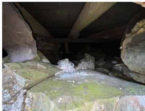
Bilde viser deler av krypkjeller.
