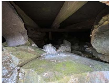
Bilde viser deler av krypkjeller.
