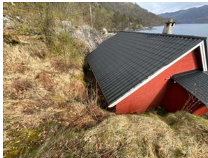
Bilde viser deler av terreng på vestsiden av fritidsbolig.
