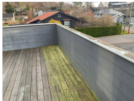
Rekkverk og gulv med grønske og malingsflass
