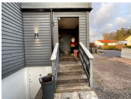
Trapp i fbm. inngangsparti.
