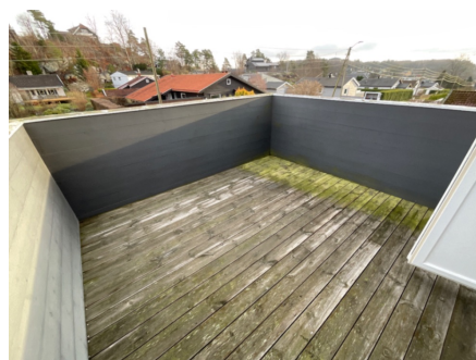
Rekkverk og gulv med grønske og malingsflass
