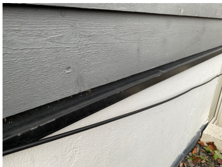
Tett for lufting i nedkant av kledning
