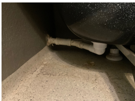
Badekar har avløp ført ut på yttervegg
